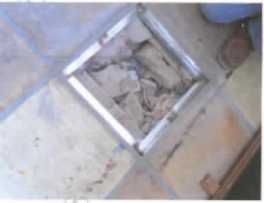
Degradació lateralis en arquetes interiors
