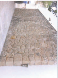
Mur de mamposteria Humiltats
