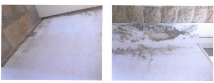
P.13 Humitat pilar Humitat mur
