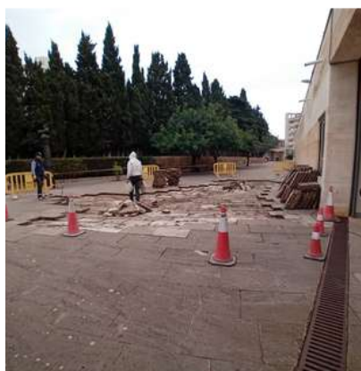
Reparació paviment N°2
