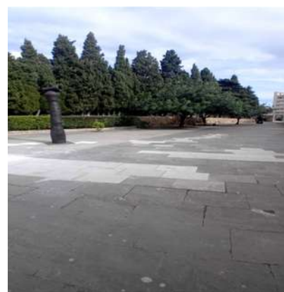
Reparació paviment N°3
